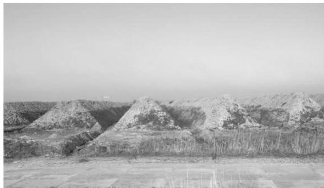
**Abb. 4:** Baggergut in Mieten zur weiteren Reifung
