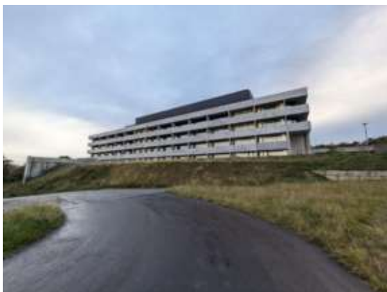
Abb. 1: Außenansicht des GUZ von Osten
