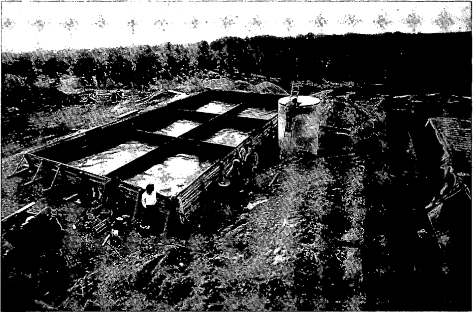
Abb. 4: Großlysimeteranlage nach Fertigstellung der Folienarbeiten des 1. Bauabschnittes. Die Oberkante des Testfeldes reicht im heutigen Endzustand bis zum Deckel des Einlaufschachtes.
