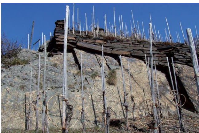
Trockenmauern im Weinbau (Foto: DLR Mosel)
